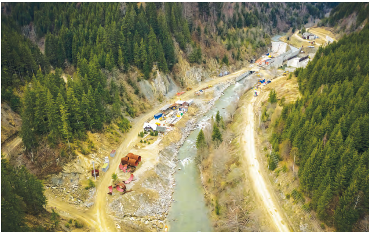
世界上只有 1/3 的河流保持着畅通无阻，而大坝是淡水连通性的主要障碍。欧洲喀尔巴阡生态区“心脏地带”具有象征意义的河流上正在修建水坝。 ©Leeway Collective（巴尔干河流）/Calin Dejeu
