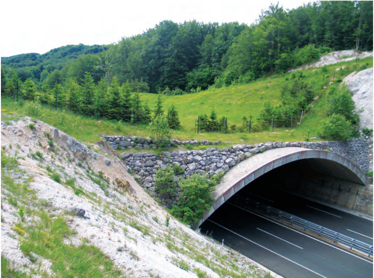
虽然野生动物穿越结构物不能代替完整的景观，但可减轻破碎化对许多物种的影响，如克罗地亚的这座高速公路立交桥，该国一共有 13 个这样的立交桥。©Djuro Huber
